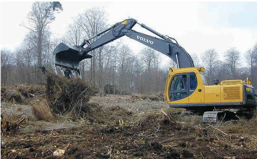
Figur 6-5. Kvasrydning med gravemaskine.
